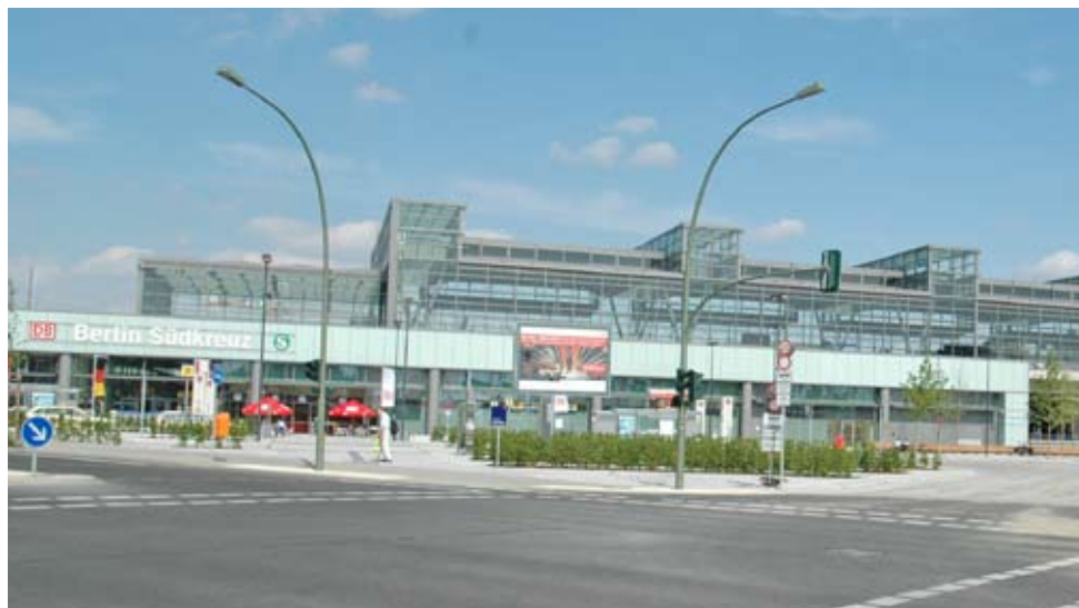
Nach vielen Jahren endlich fertig – der Bahnhof Südkreuz an der Papestraße
